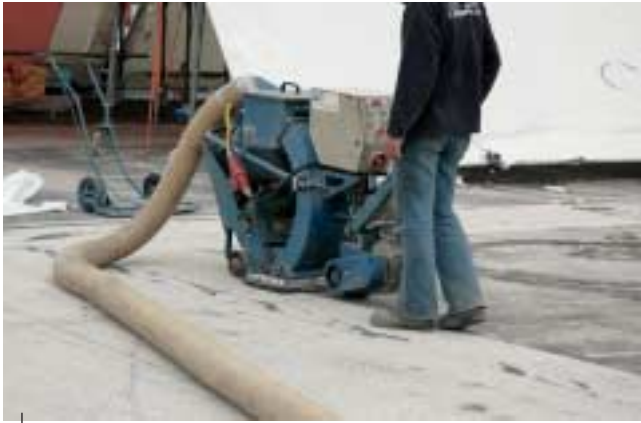
De betonnen onderconstructie wordt met stalen kogels gestraald ...
