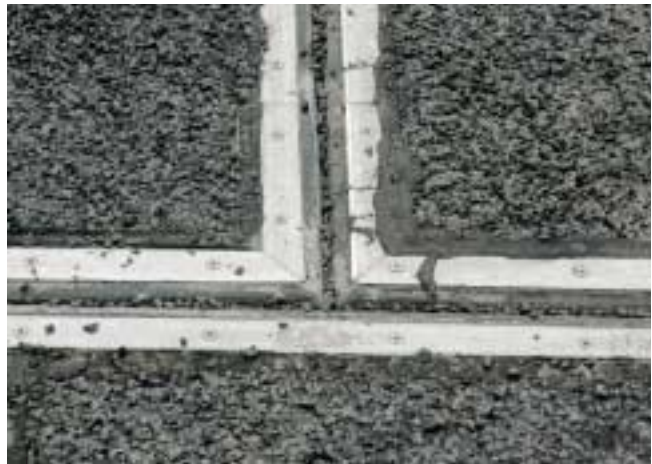
De Migutan® -dilataties zijn waterdicht ingewerkt in het Wegtapijt.
