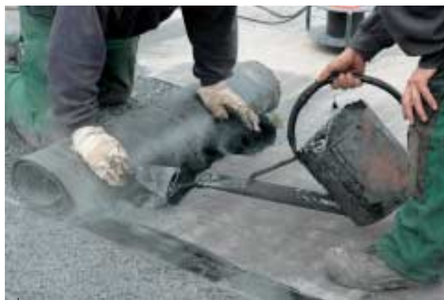
Het Wegtapijt wordt vol en zat gekleefd met SBS gemodificeerd bitumen op de SBS-onderlaag.
