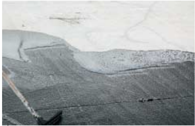
... en direct daarna voorzien van een primerlaag.
