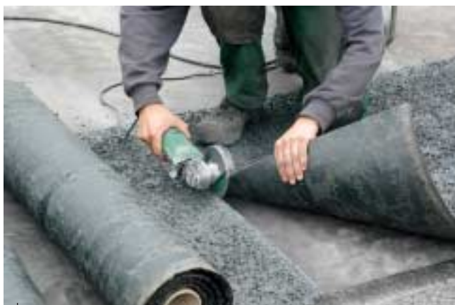
Het opmaatzen van het Wegtapijt gaat met een slijpschijf.
