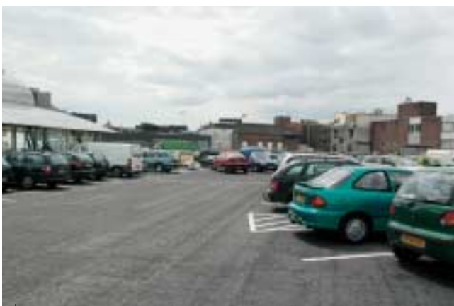
Gedurende de werkzaamheden is een deel van het parkeerdak al weer in gebruik.
