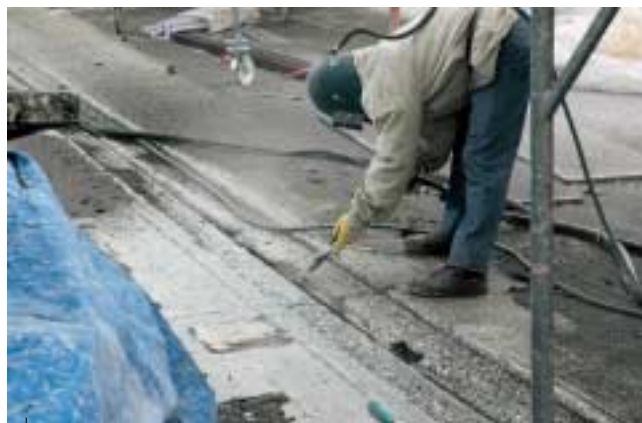
Bij de nieuwe dilatatievoegen wordt een inkeping in het beton gefreesd.
