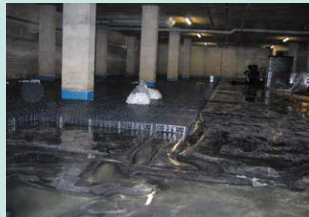
Aanbrengen van de Permavoid units. Het water op de oude ondervloer is goed zichtbaar (ondanks wegpompen).
