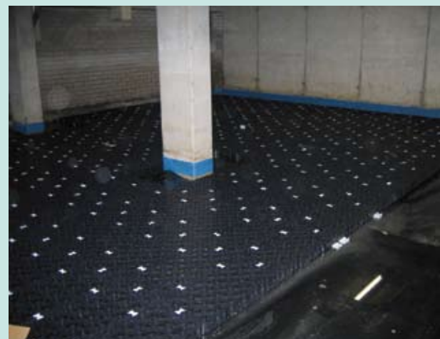
De units worden voorzien van conische verbindingspinnen
