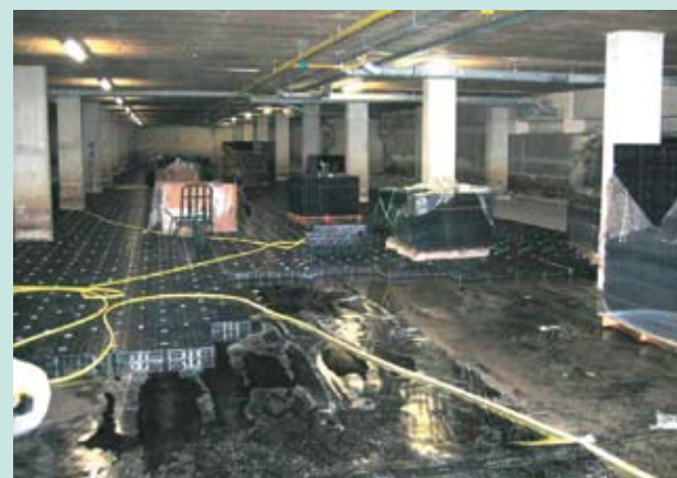
Aanbrengen van de Permavoid units. Het water op de oude ondervloer is goed zichtbaar (ondanks wegpompen).
