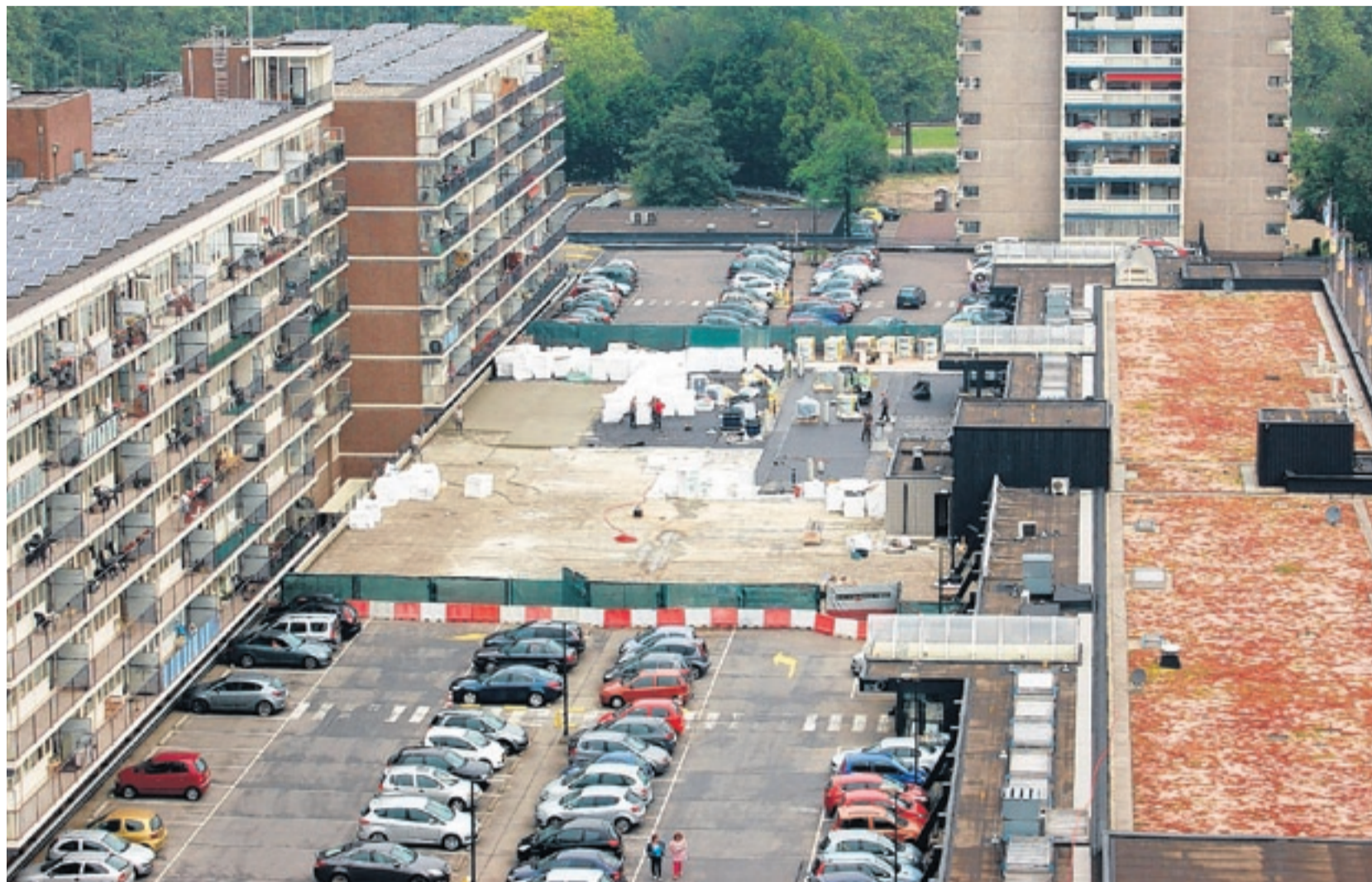
Het parkeerdak van winkelcentrum Sterrenburg wordt compleet gerenoveerd. Daarmee behoort een lekkend dak tot het verleden en ook winkelend publiek profiteert ervan.
