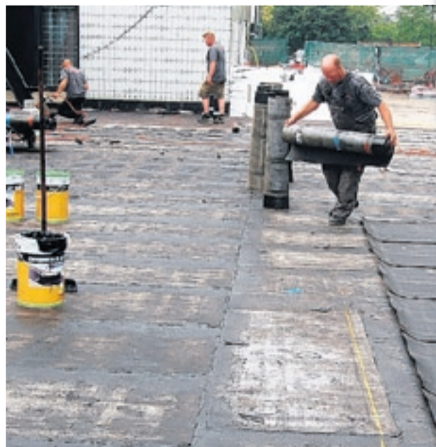
Er wordt hard gewerkt door de medewerkers van BetonRestore, dat in opdracht van Corio de renovatie uitvoert.
