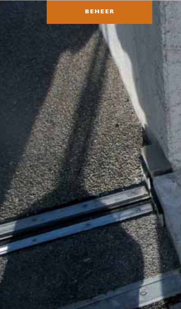
Aansluiting hellingbaan parkeerdek met Montan- en Migua-profielen.
