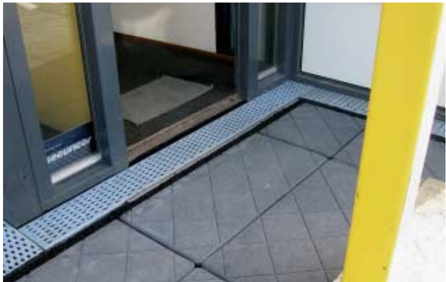
Bij lage opstanden zijn gootroosters toegepast.
