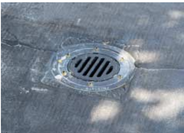
De EPDM-slabbe is geklemd en tussen de dakbedekkingslagen ingewerkt.
