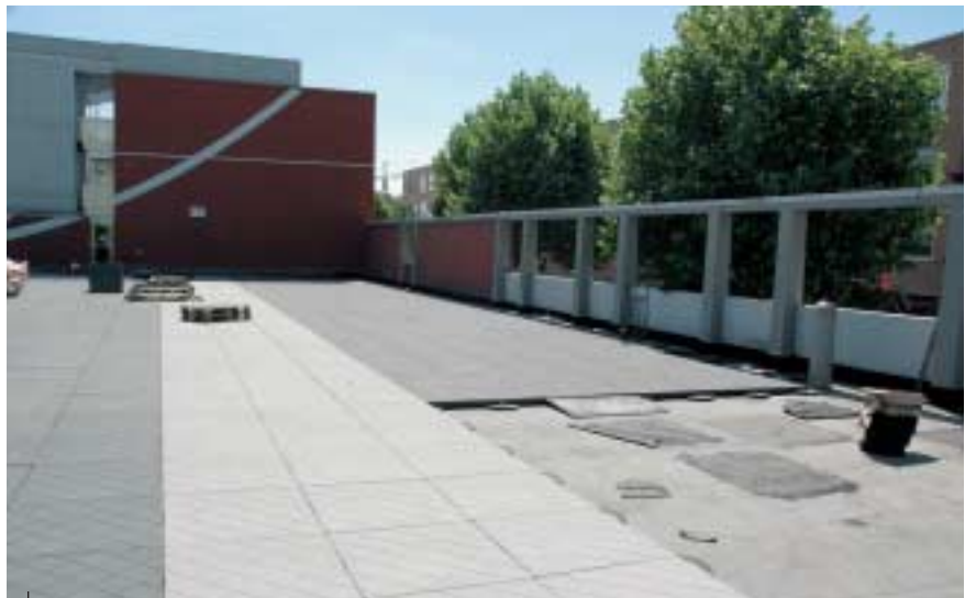
Het parkeerdak in opbouw. In het midden liggen de grijze tegels van de rijbaan.
