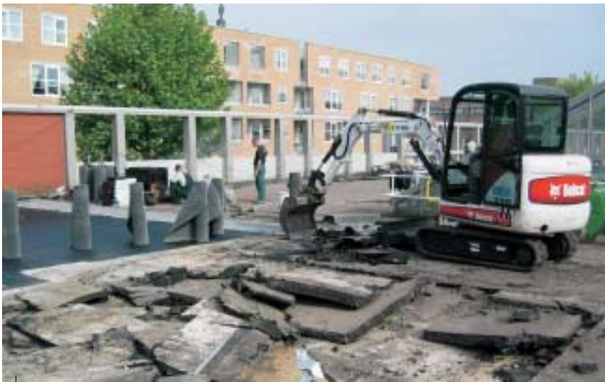
Het gesloopte deel is per dag weer waterdicht afgewerkt.
