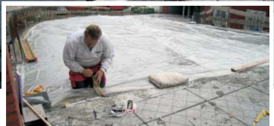
De overgang bij de hellingbaan in uitvoering.
