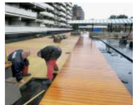
De tegels sluiten aan op het vlonderpad.
