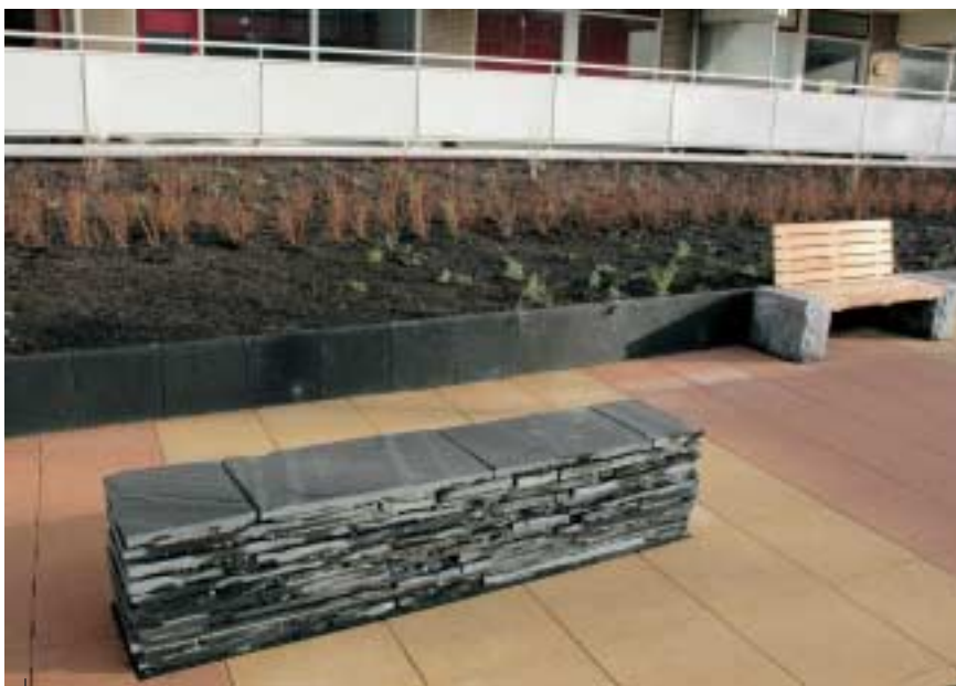
Het dakmeubilair is op tegelmaat geplaatst.
