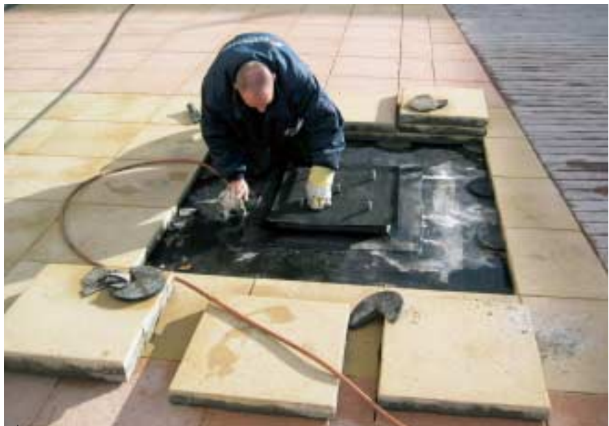
Nadat de tegelmaat bekend is worden de dakaccessoires geplaatst.
