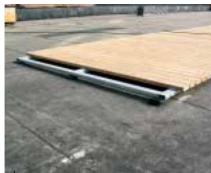
Nadat de dakbedekking is gelegd wordt het vlonderpad gelegd.
