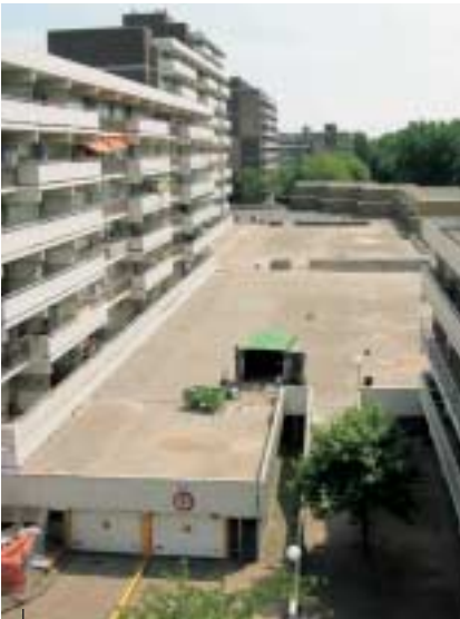
De eerste fase: het zaagwerk bij afvoeren en betonnen opstanden.
